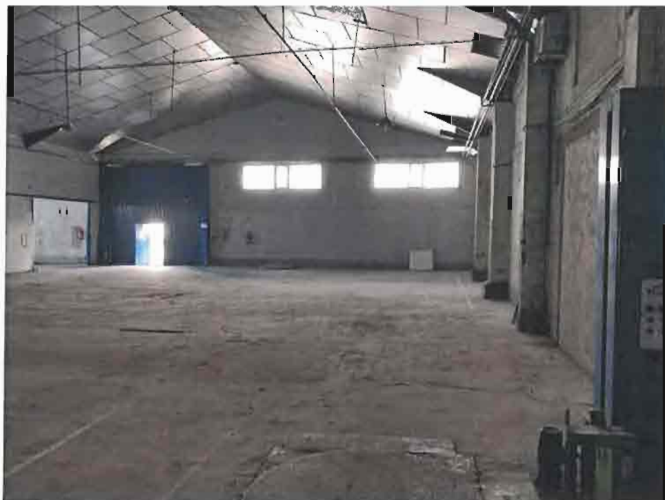
Vista interior de la crujía noreste hacia la puerta de entrada a la nave
