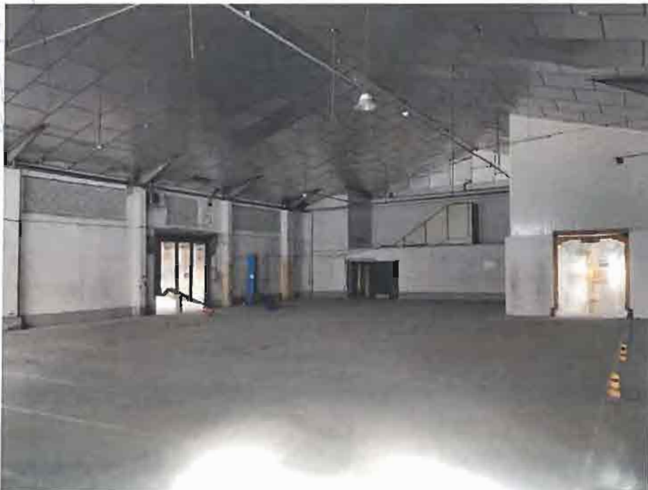
Vista interior de la crujía noreste desde la puerta de entrada
