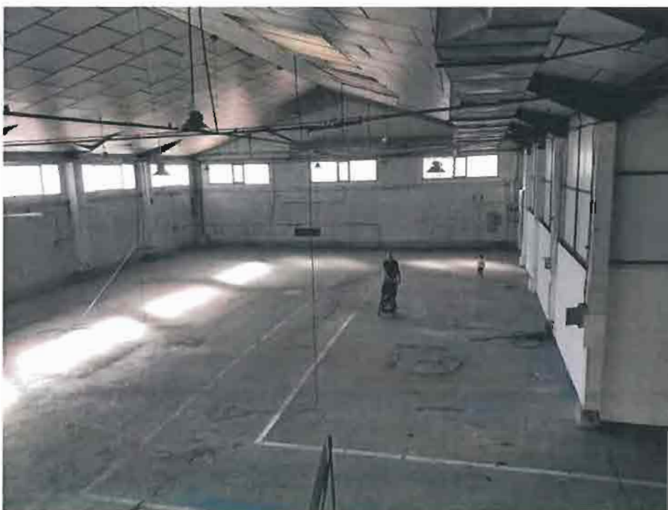
Vista interior de la crujía suroeste desde la entreplanta interior
