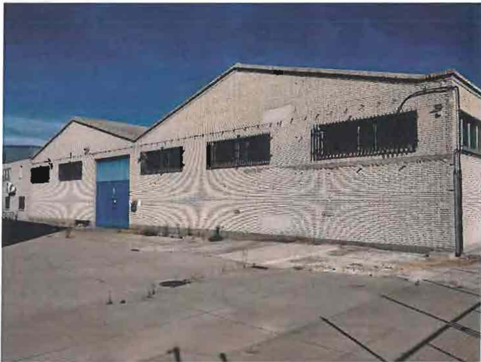
Vista de la fachada nort oeste de la nave existente
