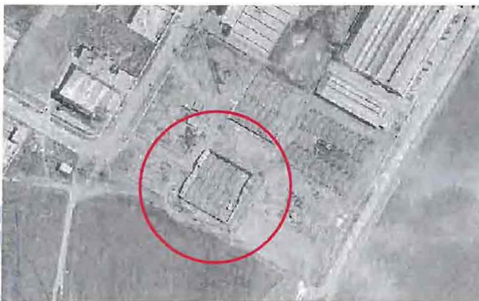
(Foto aérea de 1975 con la nave en construcción)
