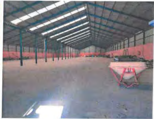
Interior de la nave (edificación principal)
