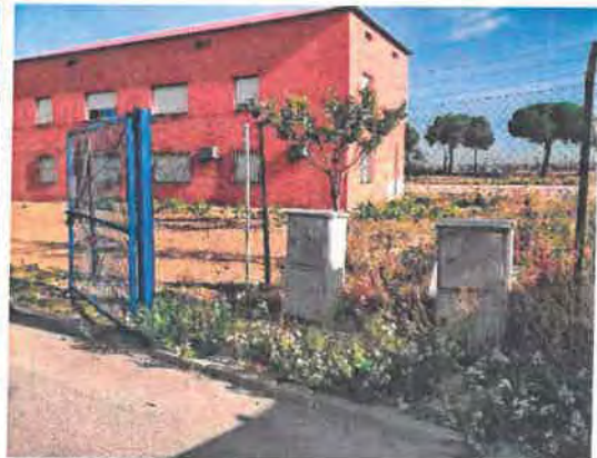
Lindero Suroeste con armario eléctrico de protección y medida de la finca
