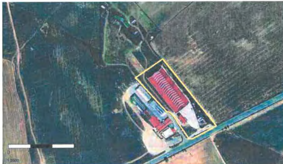
Fotografía aérea del año 1999 (Fuente: Comunidad de Madrid). Se aprecian ligeros cambios en las edificaciones de las parcelas colindantes, no así en las del ámbito del Plan Especial, que sigue sin cambios
