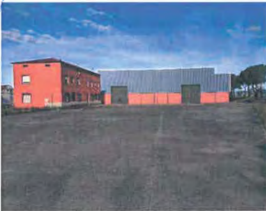
Area de entrada a la finca. Zona de maniobras y los dos edificios existentes al fondo
