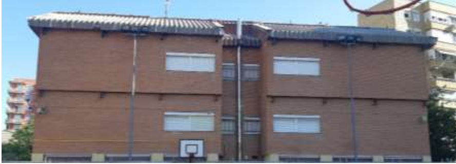
Cubierta de fibrocemento del pabellón infantil
