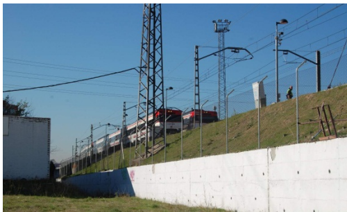
Talud y muro de separación entre el ámbito y el ferrocarril. En este tramo no circulan los trenes sino que sirve de zona de estacionamiento.
