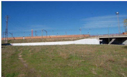
Talud y muro de separación entre el ámbito y las propiedades de Renfe-Cercanías.
