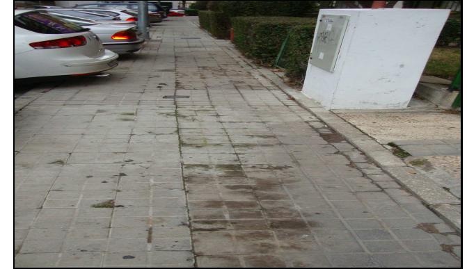
Fotografía del antes
