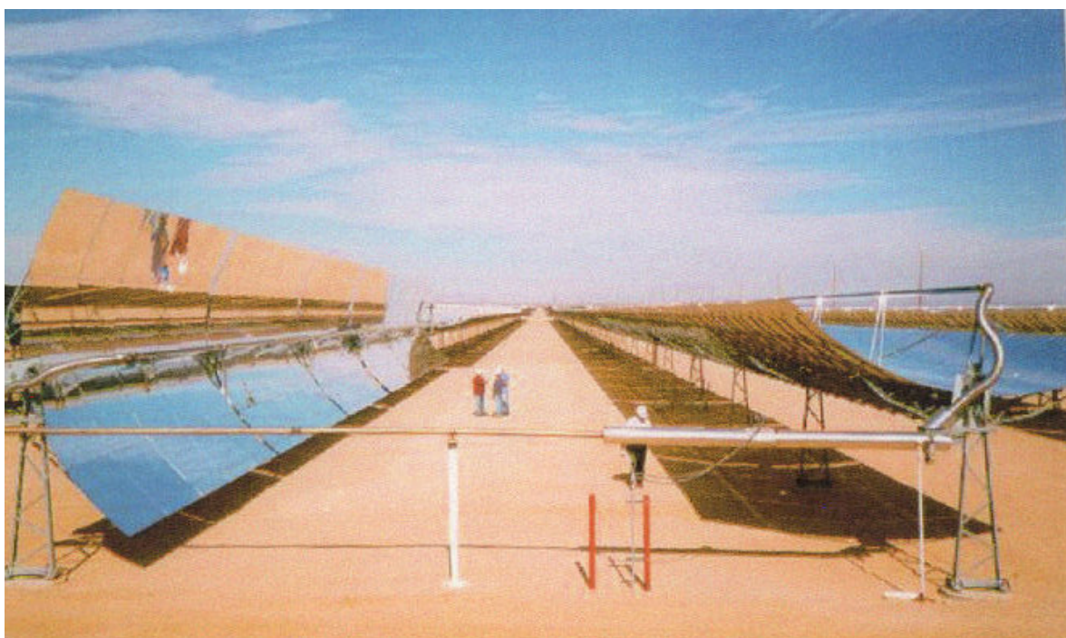
Figura 1. Instalación de colectores Cilindroparabólicos
