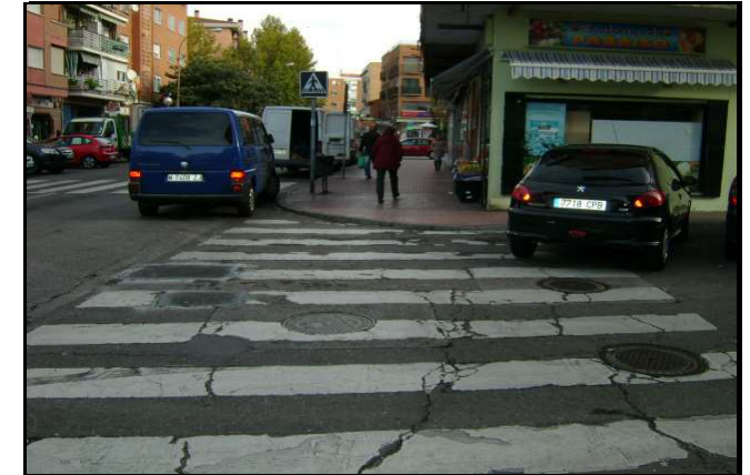
Fotografía del antes
