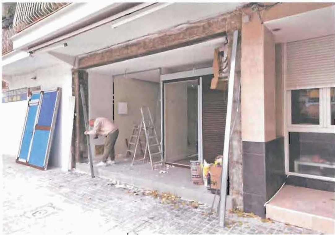
F-4 y F-5: Vista de las fachadas de los dos locales mencionados en la fotografía anterior. El primero terminado y con LPO y el segundo aún en obras, con licencia concedida.
