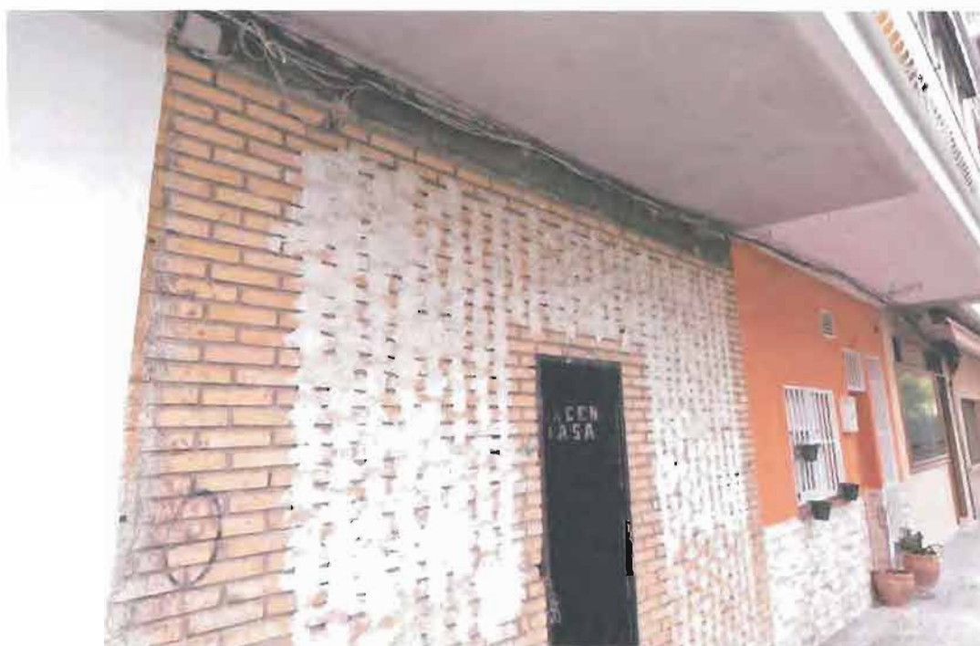
F-2: Vista de la fachada del local, mirando hacia la calle Rubens. Se observa que el local colindante por la derecha (fachada color naranja) está transformado a vivienda.
