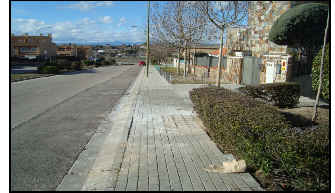
Fotografía del antes
